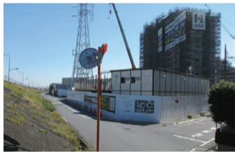
マンション建設で中止となったスーパー堤防
