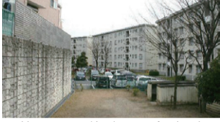
平井7丁目の絶壁スーパー堤防
