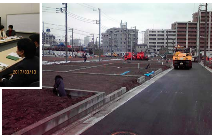
道路舗装中で完了間近だった北小岩地区
