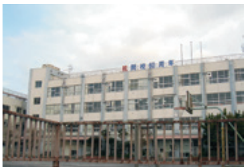
解体される二之江小学校旧校舎
